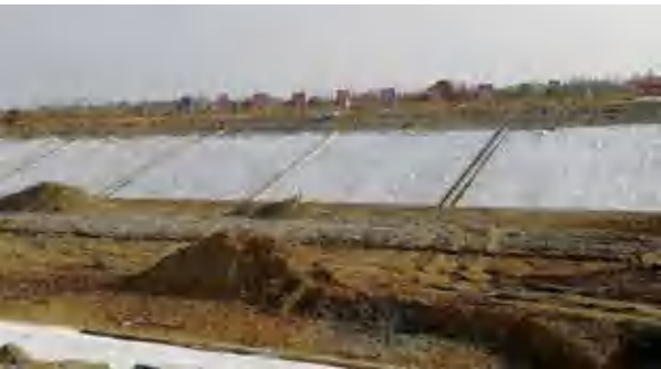
天鼎丰公司研发生产的高强粗旦聚丙烯纺粘针刺土工布应用在引江济淮工程中
