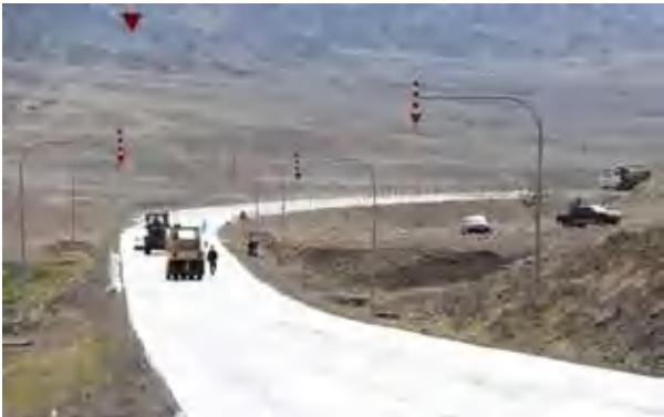
天鼎丰公司研发的聚丙烯长丝防裂基布应用于新疆公路大中修项目中
