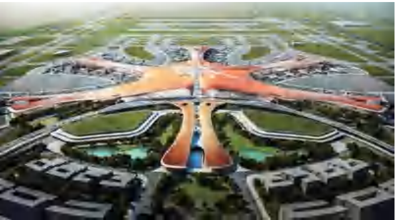
北京大兴国际机场的建设中,铺设了300万平方米由天鼎丰公司研制的高强粗旦聚丙烯纺粘针刺土工布
